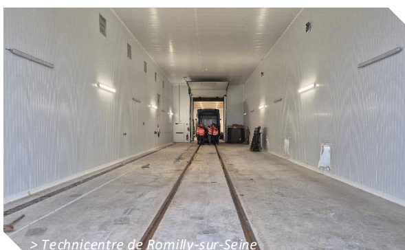
> Technicentre de Romilly-sur-Seine
